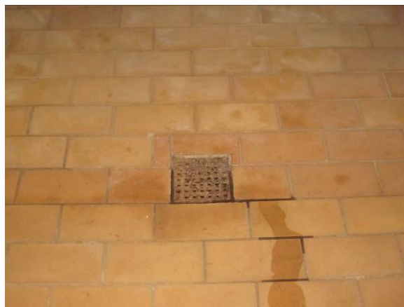
Gulvafløb sektion 2 og afløbsrør via tank
