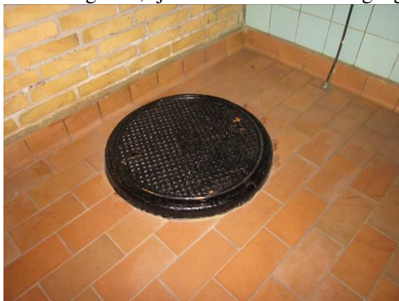
For lavt nedgangsdæksel til rentvandstank
