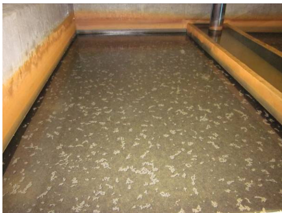
Kalkskaller på filtre i vestside
