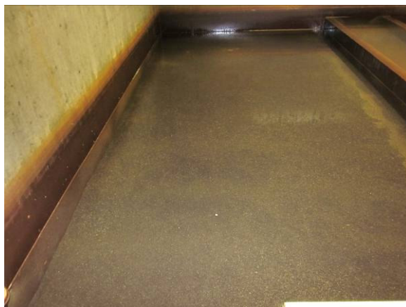
Filtre i østside uden kalk
