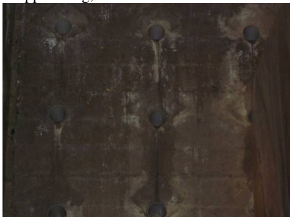
Naturlig ventilation, tilbageløb fra yderside
