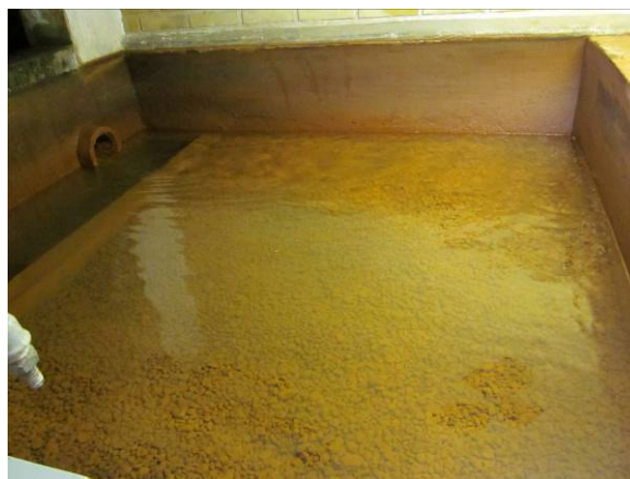
Kontaktfilter sektion 2, ikke skyllet rent
