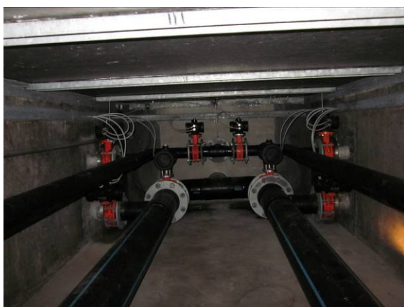
Rørgang i sektion 4
