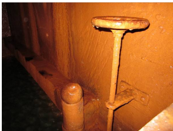
Bundventil til reaktionsbeholder, sektion 3
