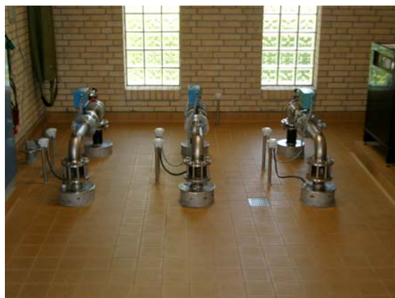
Rentvandspumperne på Nybrovejens Vandværk kan levere op til 170 m 3 drikkevand i timen.
