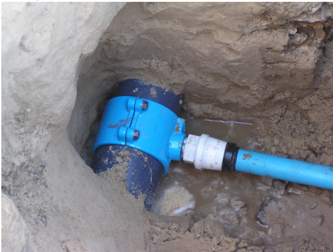
Figur 5: Tilslutning af stikledning.
