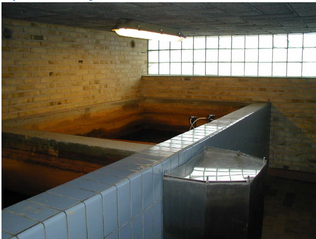
Figur 2: Efterfilter sektion 2
