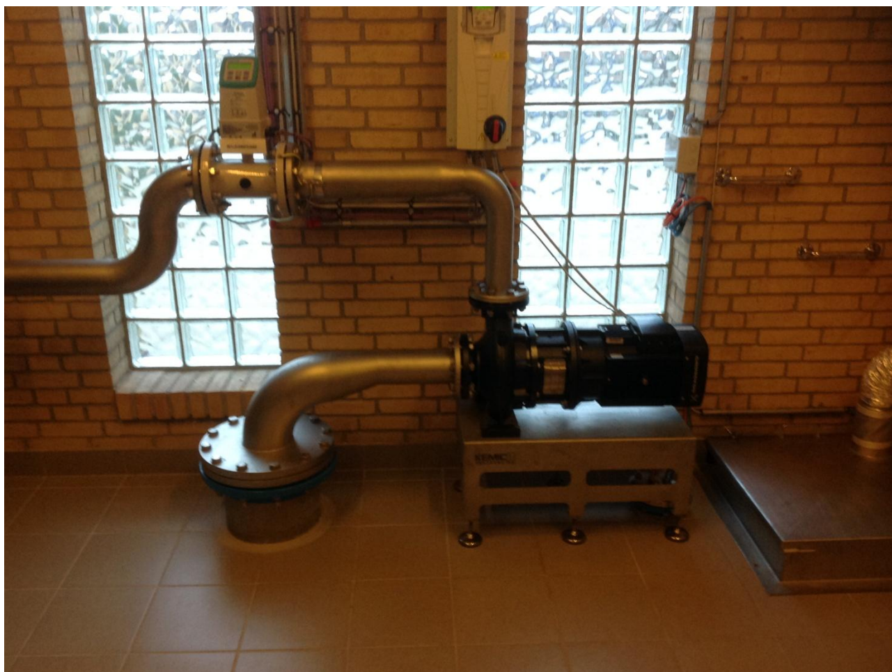
Figur 2: Skyllevandspumpe sektion 4
