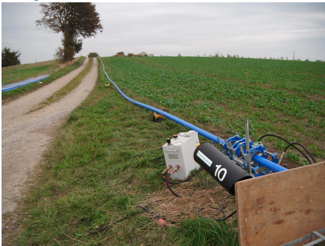
Figur 5: Stuksvejsning af ny forsyningsledning
