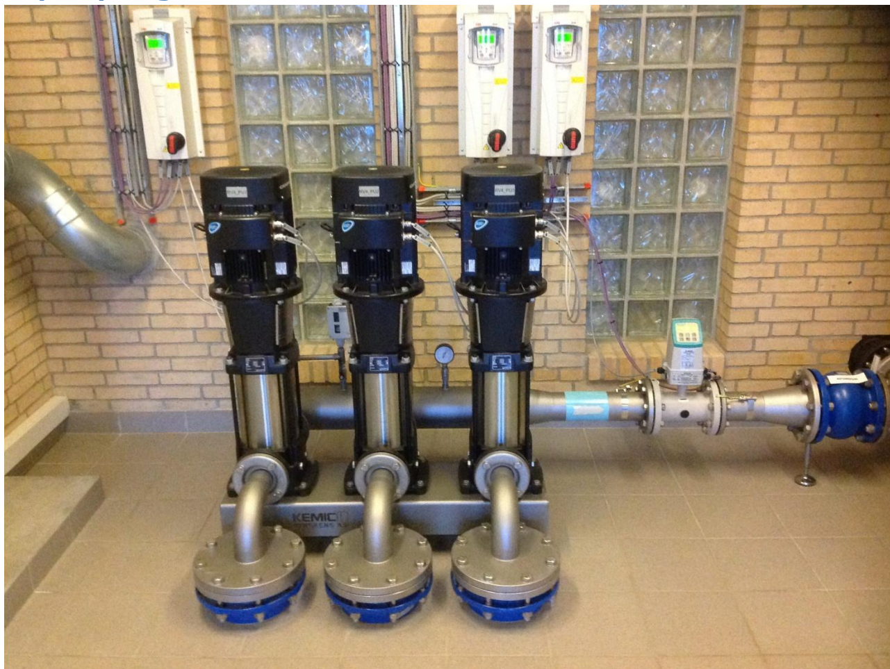
Figur 3: Rentvandspumper sektion 4.
