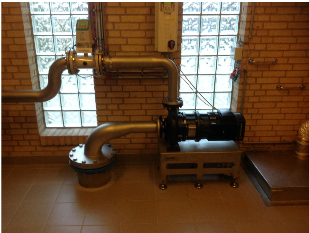
Figur 2: Skyllevandspumpe sektion 4
