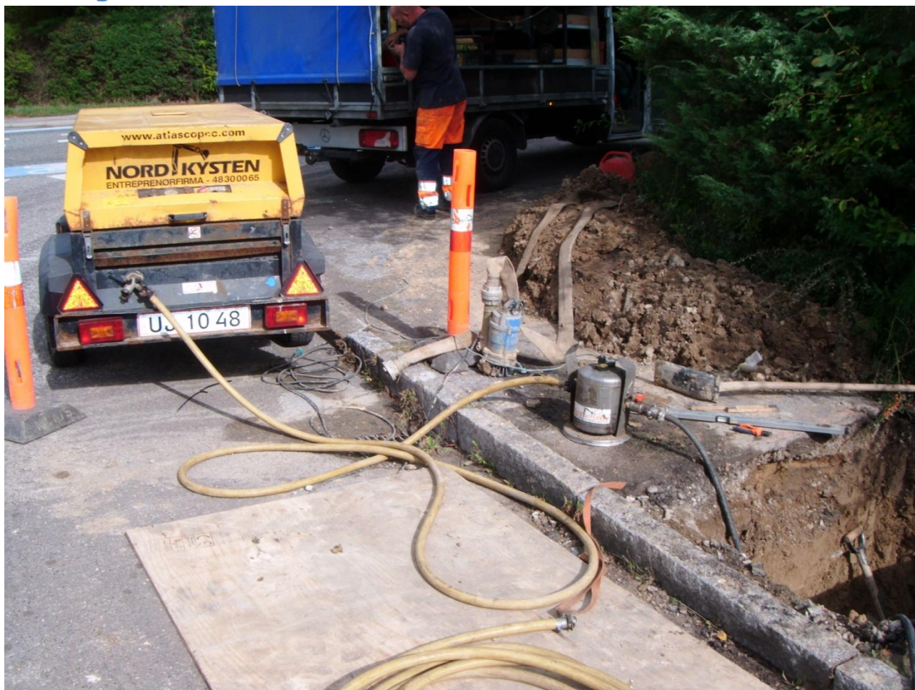
Figur 5: Skydning af ny stikledning.
