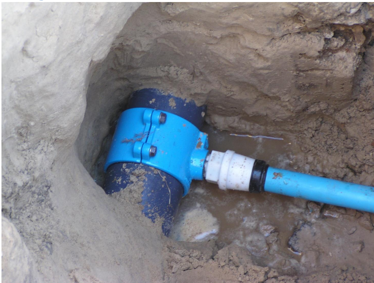
Figur 5: Tilslutning af stikledning.
