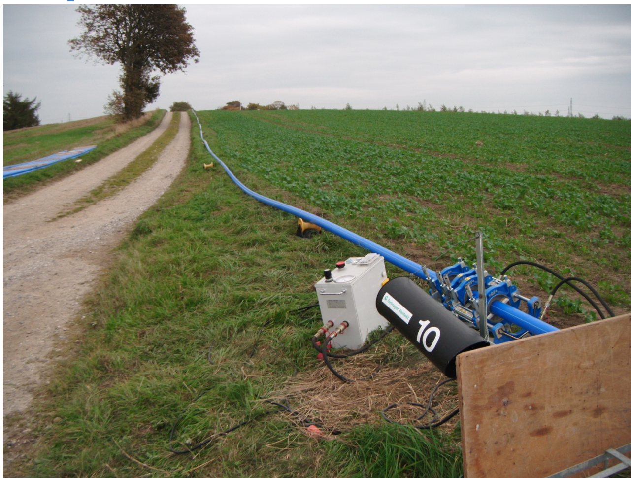
Figur 5: Stuksvejsning af ny forsyningsledning
