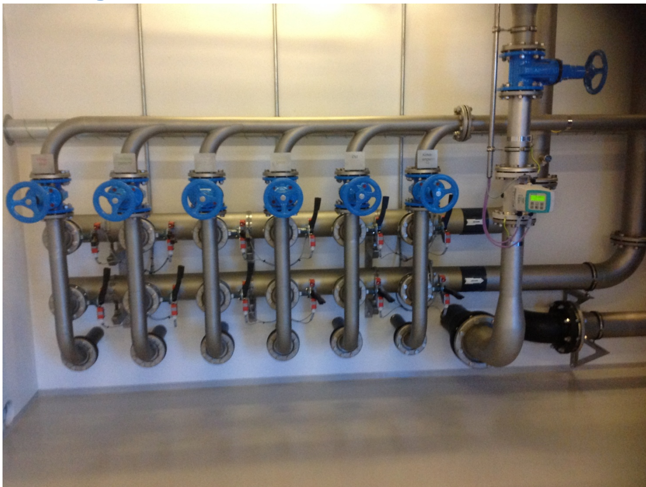
Figur 1: Fordelingsarrangement for råvand, kaldet vandorglet.
