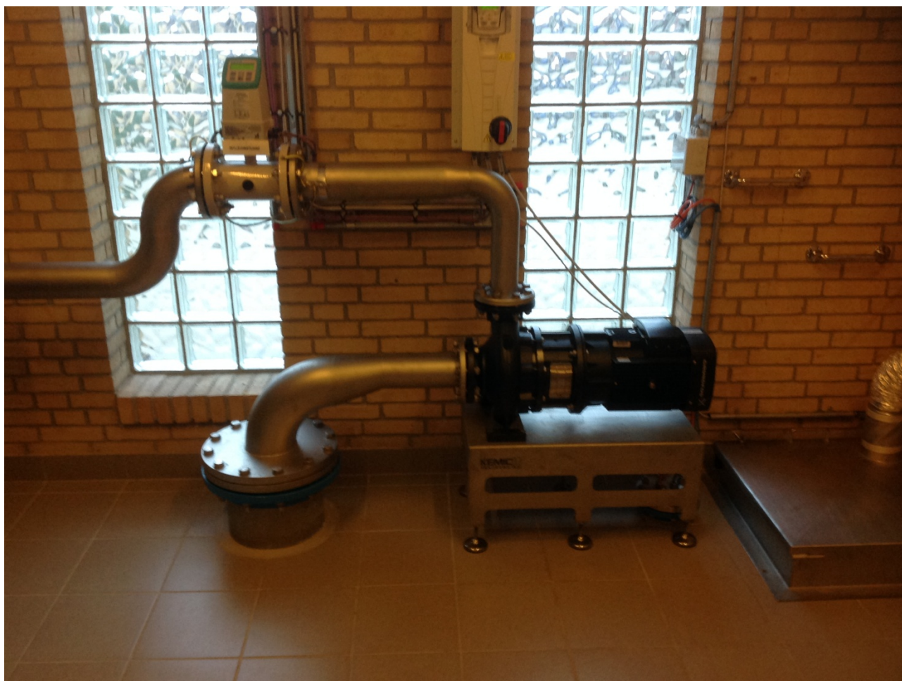
Figur 2: Skyllevandspumpe sektion 4
